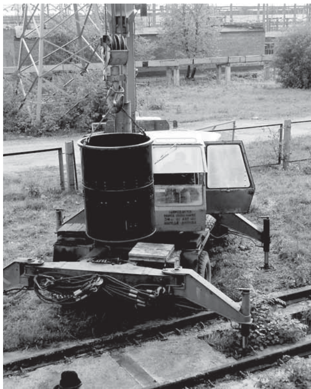
Рис. 1.31. Монтаж регулятора под нагрузкой на силовой трансформатор с помощью подъёмного механизма.
